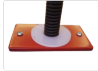
Plastmasas blīvģredzena pareizs uzstādījums
